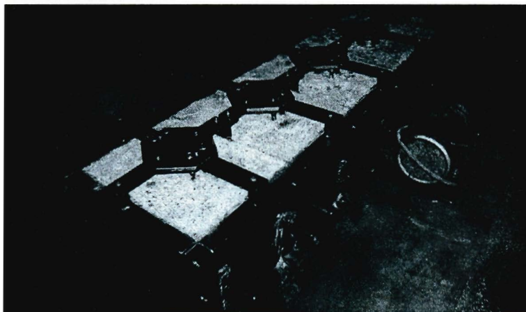
Rys. 3. Sześciokomorowa forma z przyczepnym wibratorem i szablonami do śrub kotwiących – po zabetonowaniu fundamentów.
