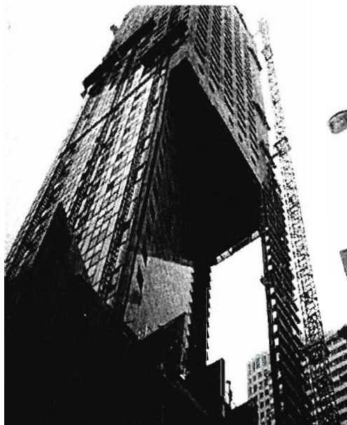
Fot.6. Widok realizacji robót elewacyjnych na części elewacji hotelu Inter-Continental w Warszawie
