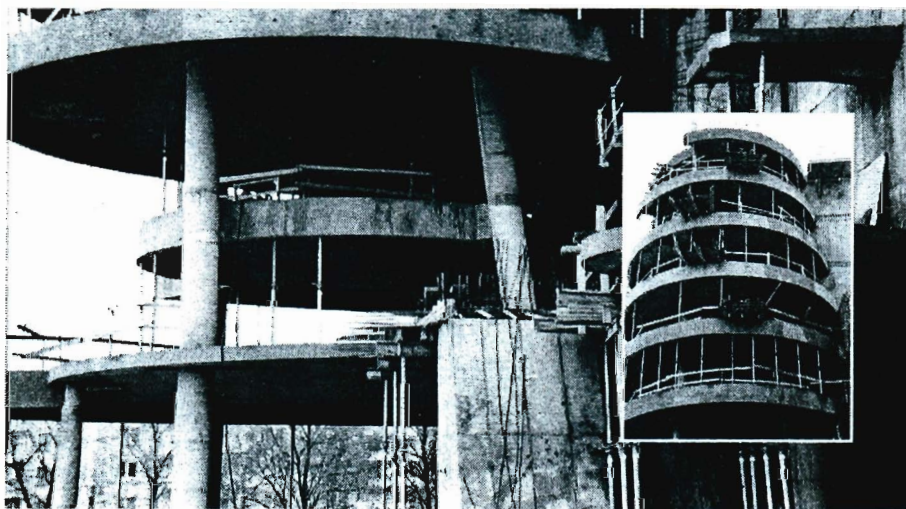
Rys. 1. Realizacja architektonicznej koncepcji, w której przyjęto słupy pochyłe
